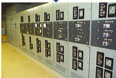
1号機 電源盤 (P/C 1C-1) 据付後
