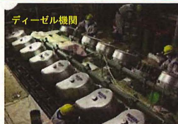
1号機 非常用D/G (A) 復旧作業
