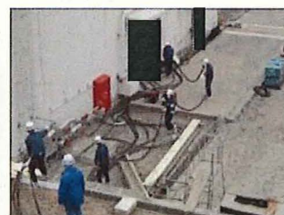
仮設ケーブルの布設の様子
