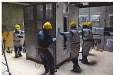
1号機 電源盤 (P/C 1C-1) 据付作業
