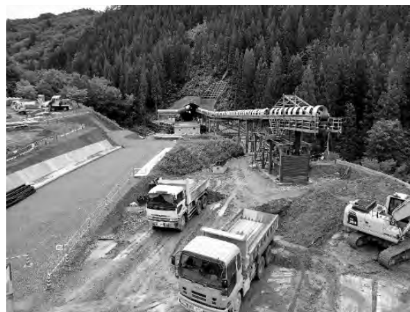
ベルトコンベアによるズリ搬出
