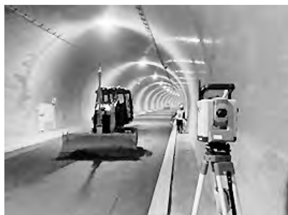
ICT施工状況
