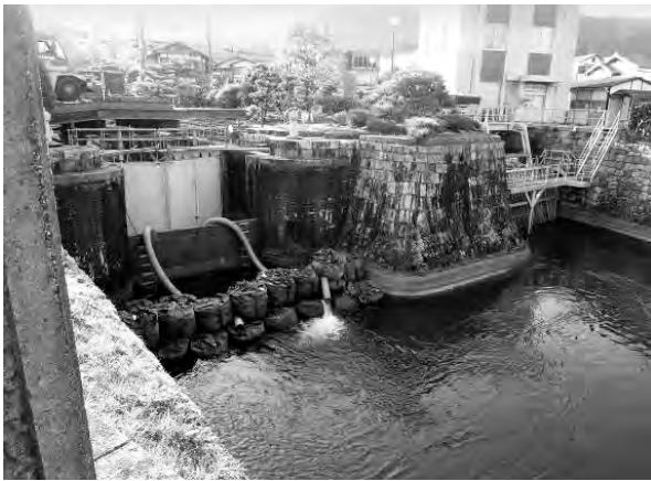
電動化工事中
