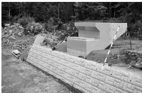
写真3.1 A2橋台付近の進捗状況
