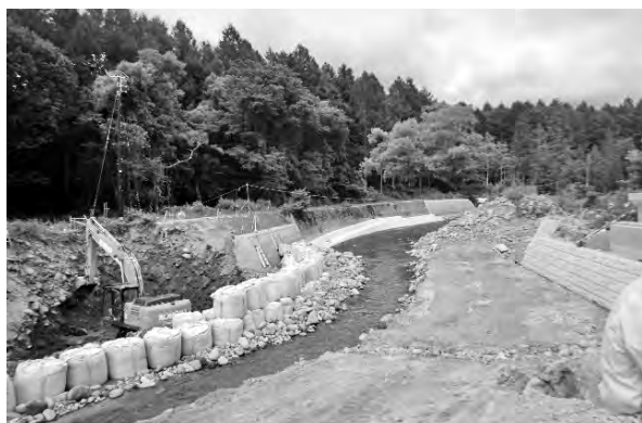
写真3.2 A1橋台付近の施工状況
