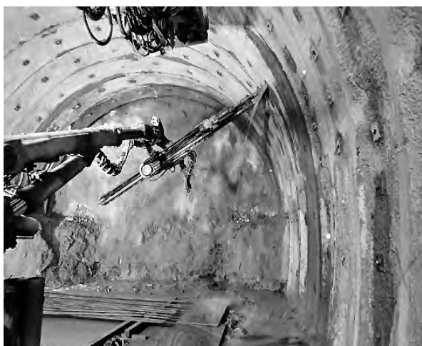
博士トンネル掘進状況
