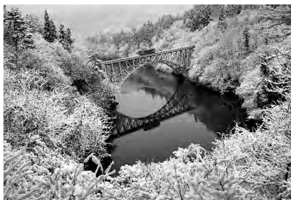
冬の第一只見川橋梁（三島町）
