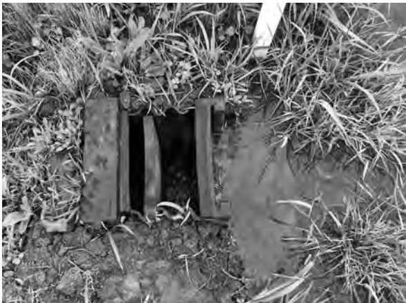
図-4 田んぼダム排水装置 上：フリードレーン、下：軽量落水柵
