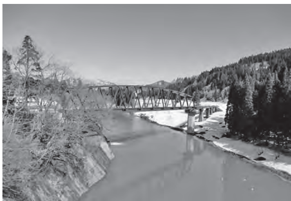
復旧した第七只見川橋りょう（金山町）
