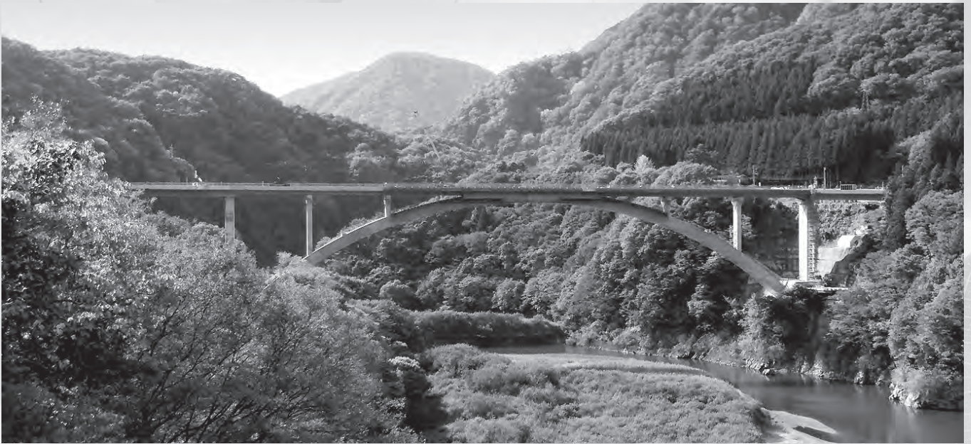
国道118号(仮称)下郷大橋上部工事
