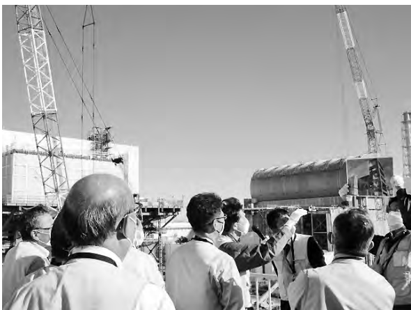
降車による原子炉建屋の外観俯瞰状況
