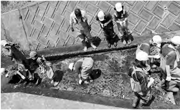
写真3. 水路側への炭設置作業
