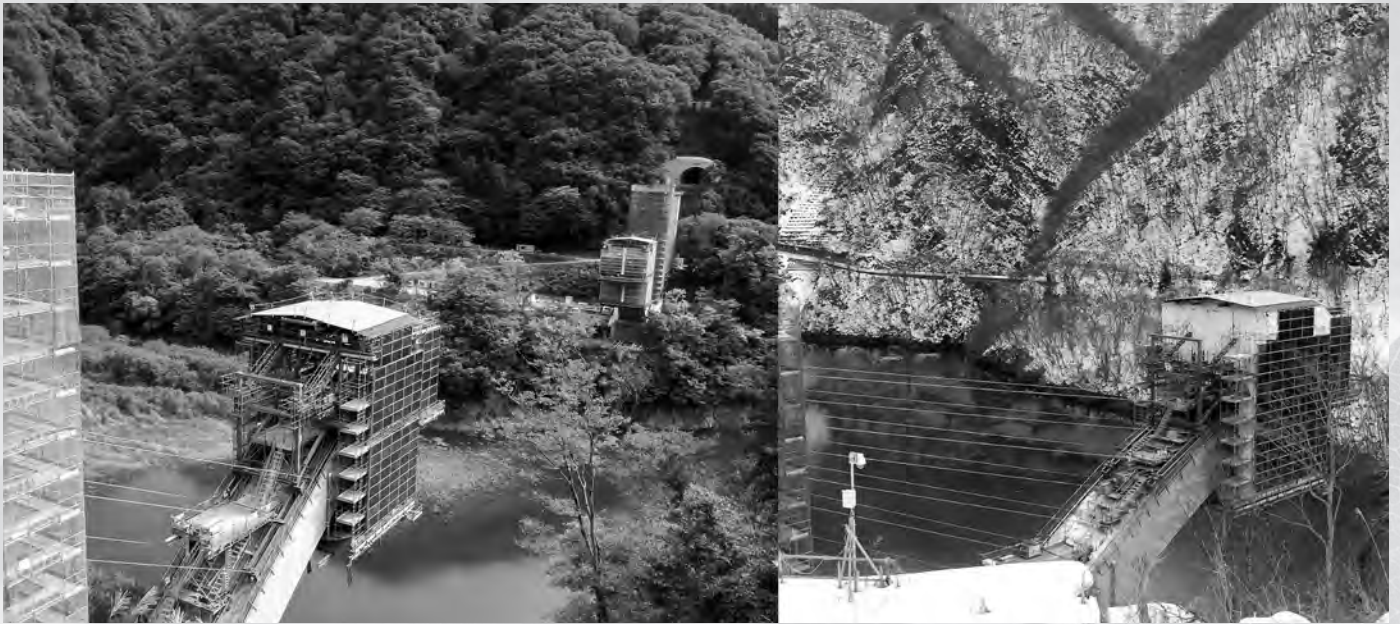
国道118号(仮称)下郷大橋上部工事
