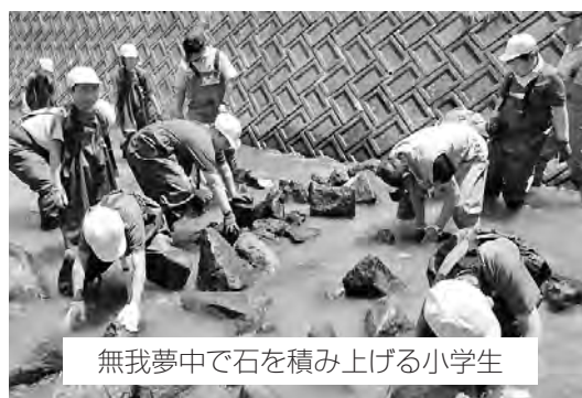
写真3. 堰の構築の様子(2020年6月撮影)
