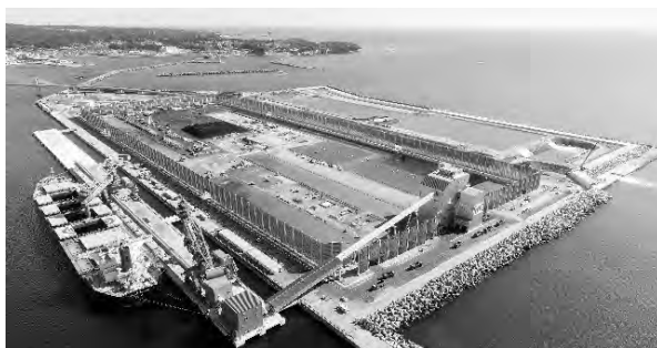
写真3 小名浜港国際バルクターミナルの供用状況
