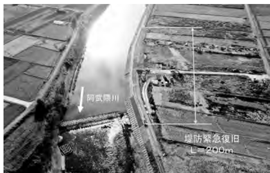
図15 矢吹町明新東地先の緊急復旧状況 (11/22撮影)
