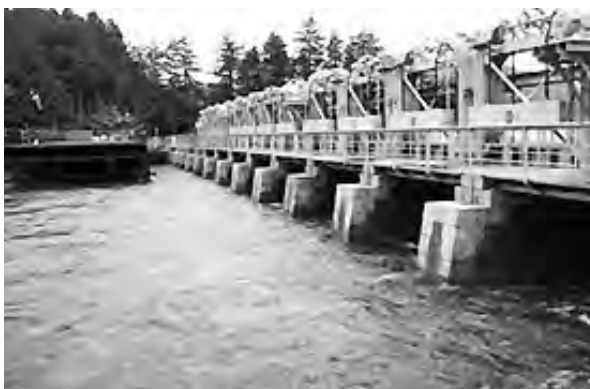
写真-4 平成16年の洪水処理状況
