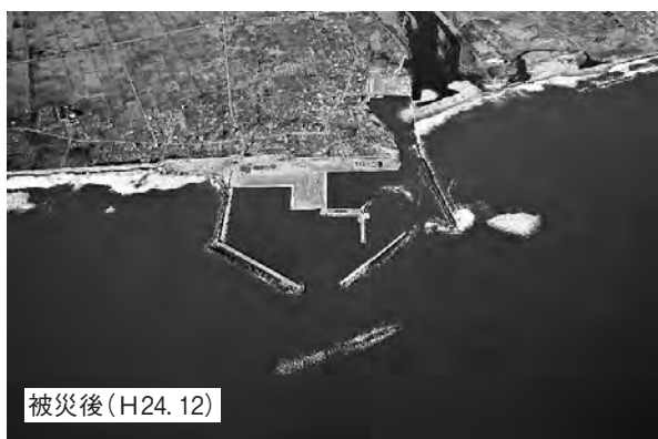
写真8 被災後の請戸漁港（浪江町）
