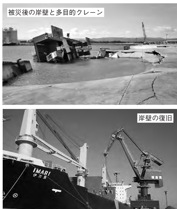
写真2 相馬港岸壁の被災と復旧
