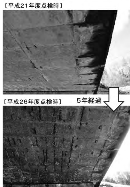
写真-5 RC床版橋の下面
