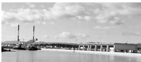
写真9 請戸漁港の復旧状況（浪江町）
