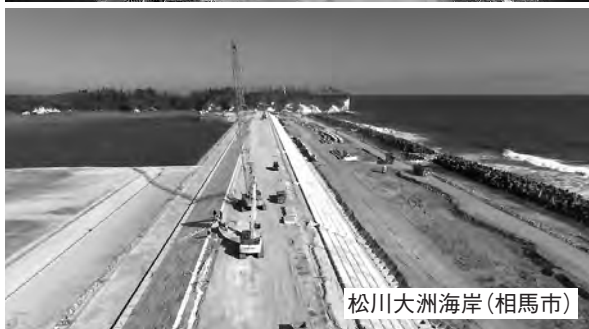
写真6 海岸堤防の復旧状況
