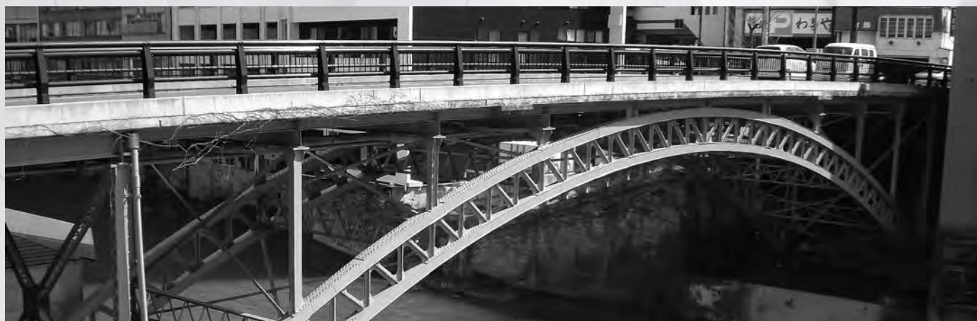
十綱橋（福島市）〔土木学会選奨土木遺産〕
