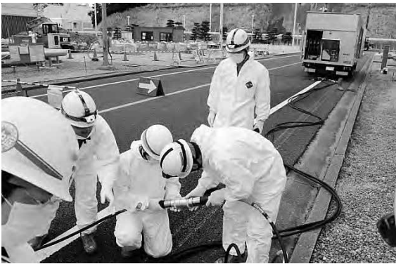
電源ケーブル接続訓練
