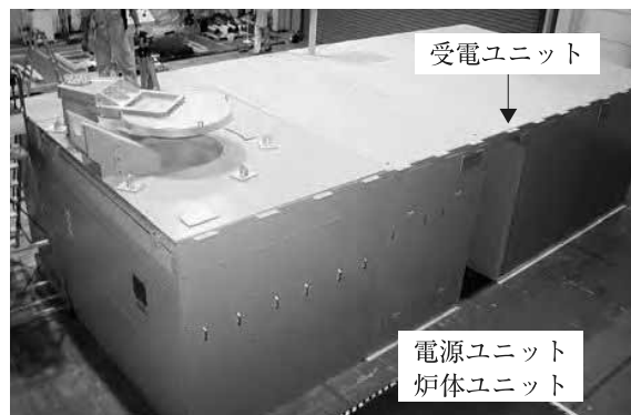
写真1. ユニット型誘導炉 (2400kW—500Hz—3 ton)
