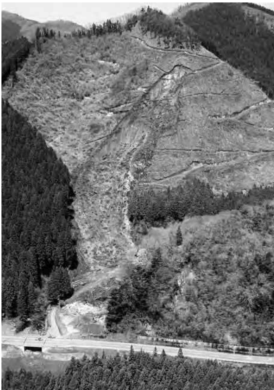
写真－４ 綱木地区の崩落状況
