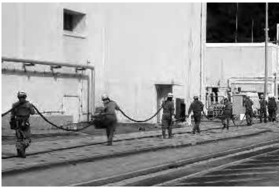
仮設ケーブルの布設
