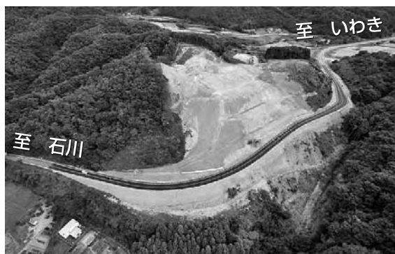
写真-1 上釜戸地区 (H23. 8. 30仮開通時)
