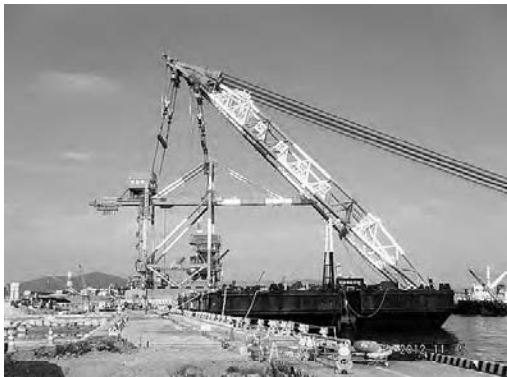
(1,400 t 吊りクレーン船による 5号埠頭ガントリークレーン設置状況)
