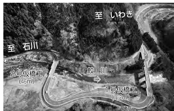
写真-2 才鉢地区 (H23. 9. 20仮開通時)
