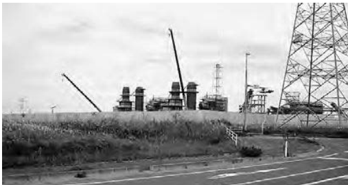
写真－2 仮設焼却炉建設状況（相馬市）
