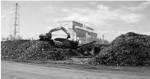
写真－1 震災がれき仮置場（新地町）
